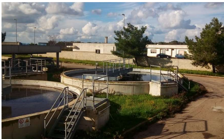
Figura 7 - Vasche di decantazione secondaria dell'impianto di depurazione di Taurisano
