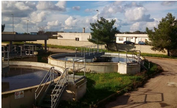
Figura 6 - Vasche di decantazione secondaria dell'impianto di depurazione di Taurisano
