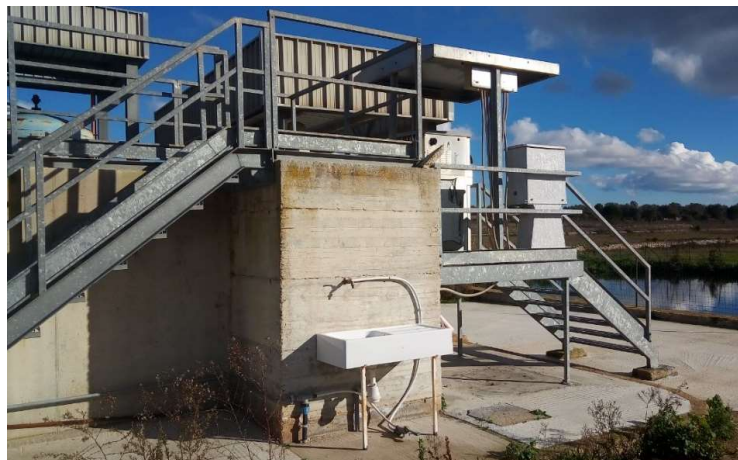
Figura 7 - Vasca di accumulo acque filtrate
