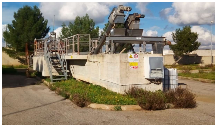
Figura 4 - Pretrattamenti dell'impianto di depurazione di Taurisano
