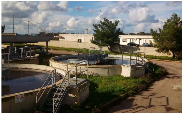
Figura 8 - Vasche di decantazione secondaria dell'impianto di depurazione di Taurisano
