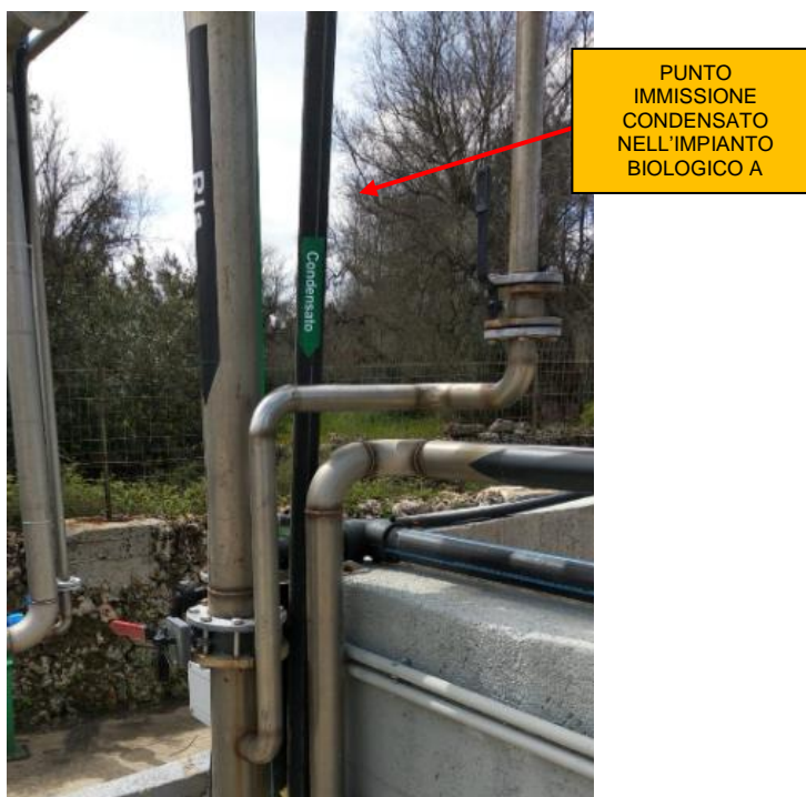
Figura 6 – Modulo Biologico A con indicazione punto immissione condensato
