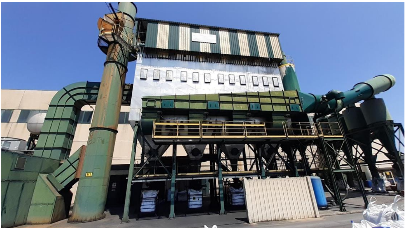
Fig.8 – Impianto di abbattimento fumi forno fusorio e forno di attesa
