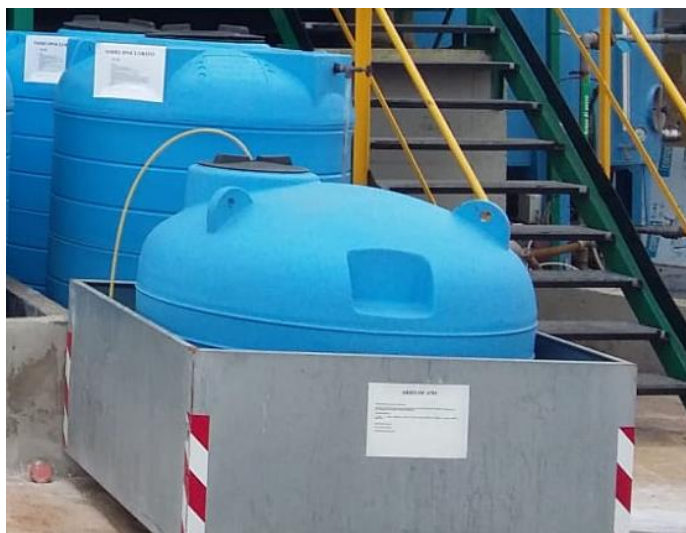
Figure 2 – Serbatoi flocculante
