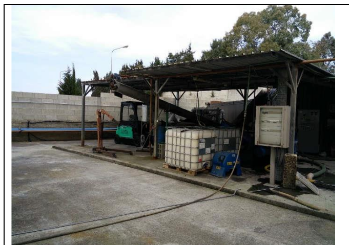
Figura 2– Centrifuga fanghi
