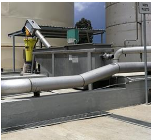
Fig. 1.8 – Macchina pretrattamento bottini
