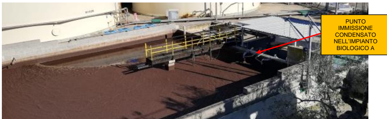
Figura 7 – Modulo Biologico A con indicazione punto immissione condensato
