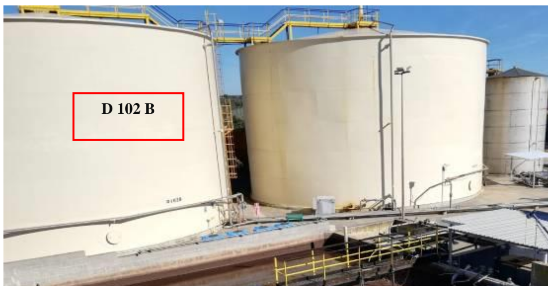
Figura 3– Serbatoio D102B alimento del serbatoio D104B
