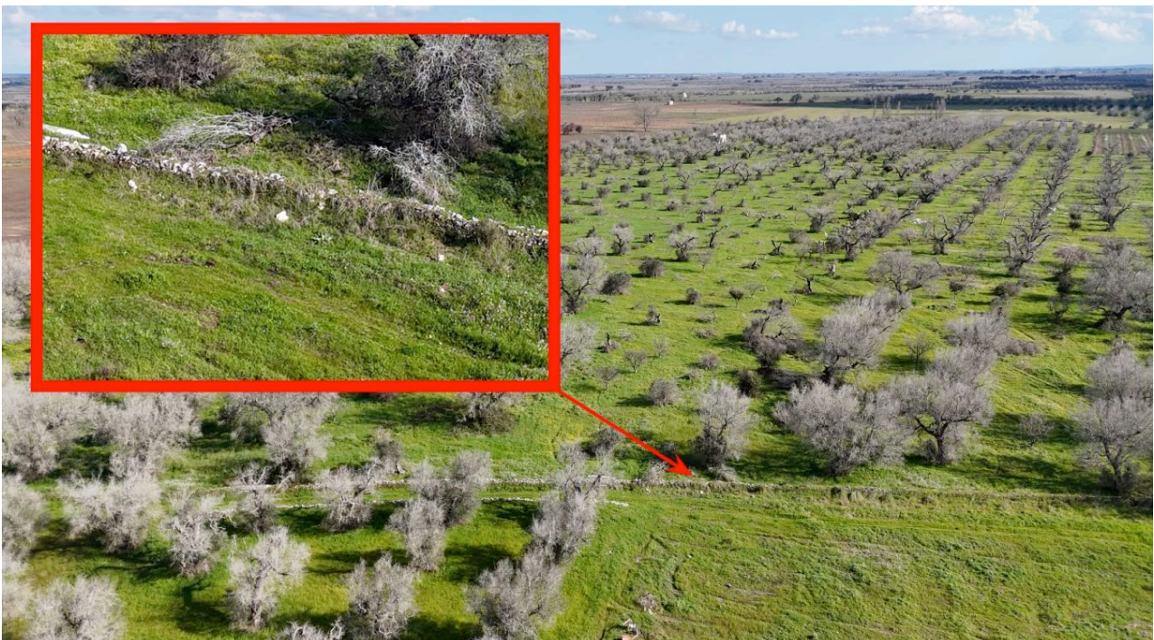
Figura 6 – Muri a secco sul confine del lotto con la Strada Comunale Sant'Elia Agne
