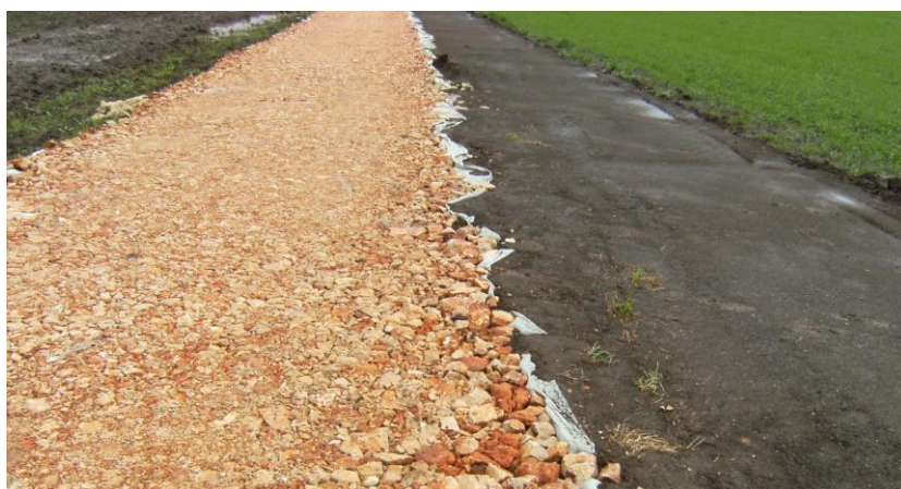
Figura 12 - Dettaglio costruzione viabilità interna con terreno stabilizzato
