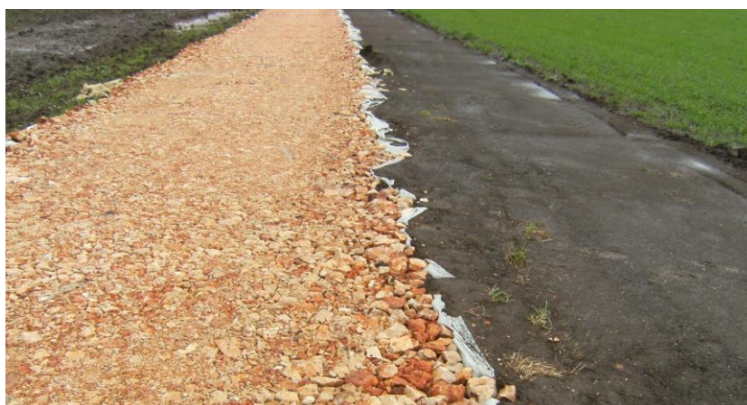
Figura 18 - Dettaglio costruzione viabilità interna con terreno stabilizzato
