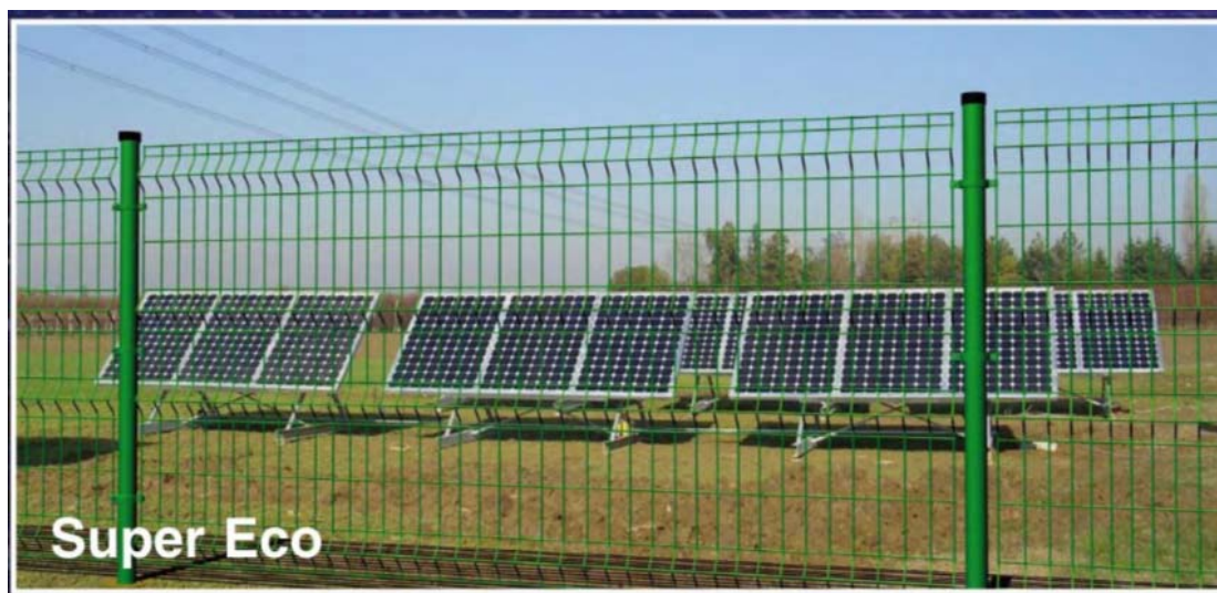
Fig. 3.10: Tipico della recinzione perimetrale ( in quella in progetto sarà sempre lasciata una luce libera di 10 cm da terra )
