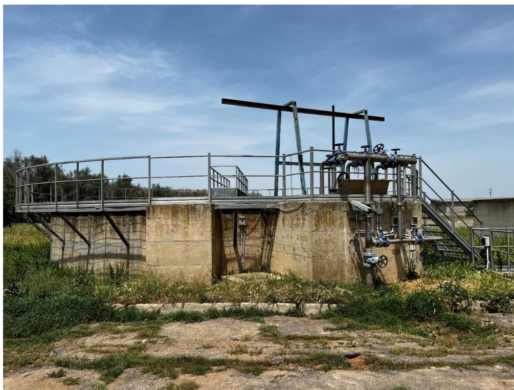
Figura 7: Sedimentazione secondaria
