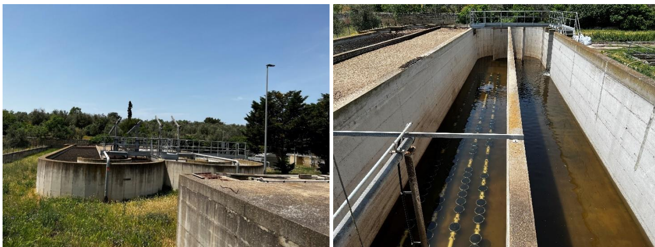
Figura 6: Comparto biologico – nitrificazione denitrificazione
