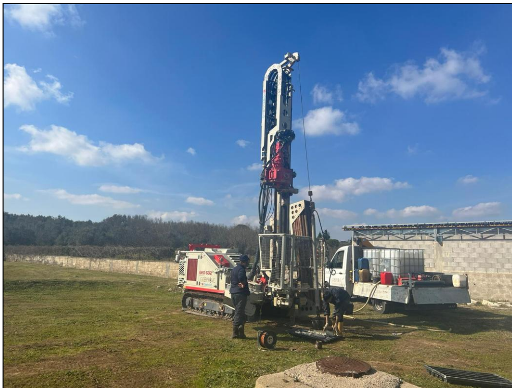
Esecuzione sondaggio geognostico S1
