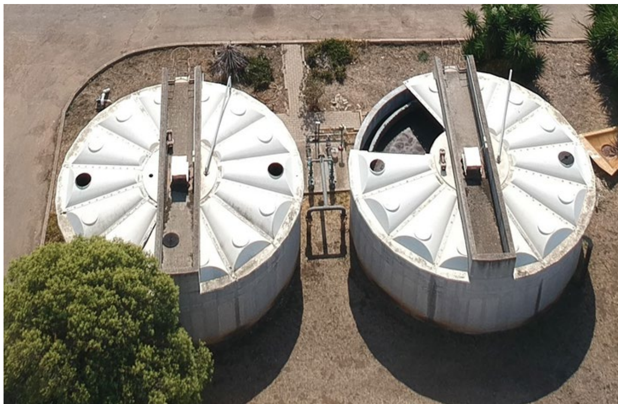
Figura 27 – Comparto di ispessimento fanghi
