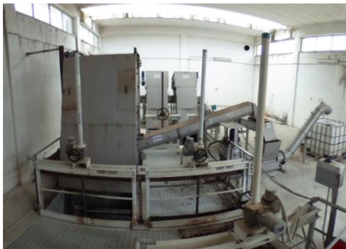
Figura 5 – Comparto di grigliatura
