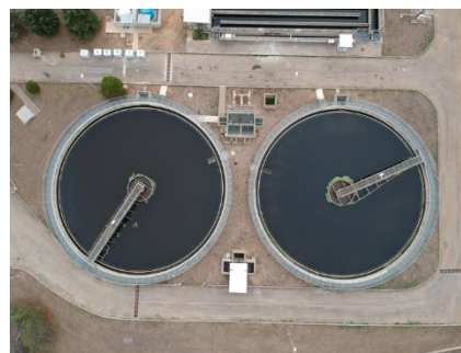
Figura 15 - Vista sulla sedimentazione secondaria
