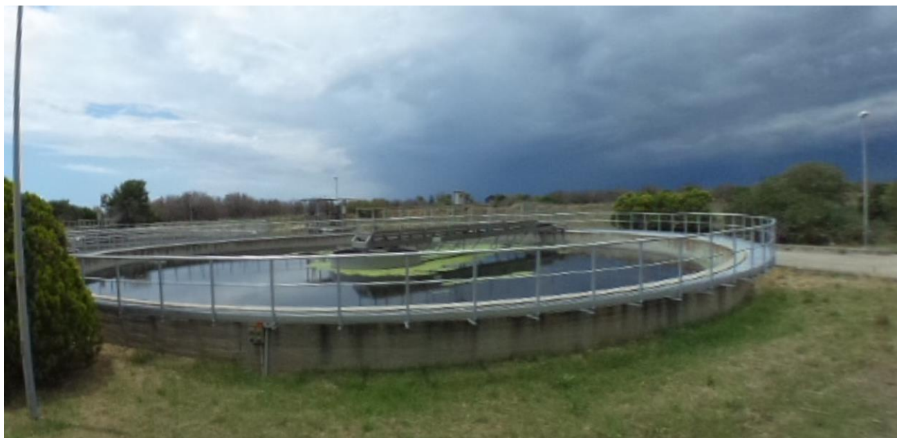
Figura 15 – Comparto di sedimentazione secondaria
