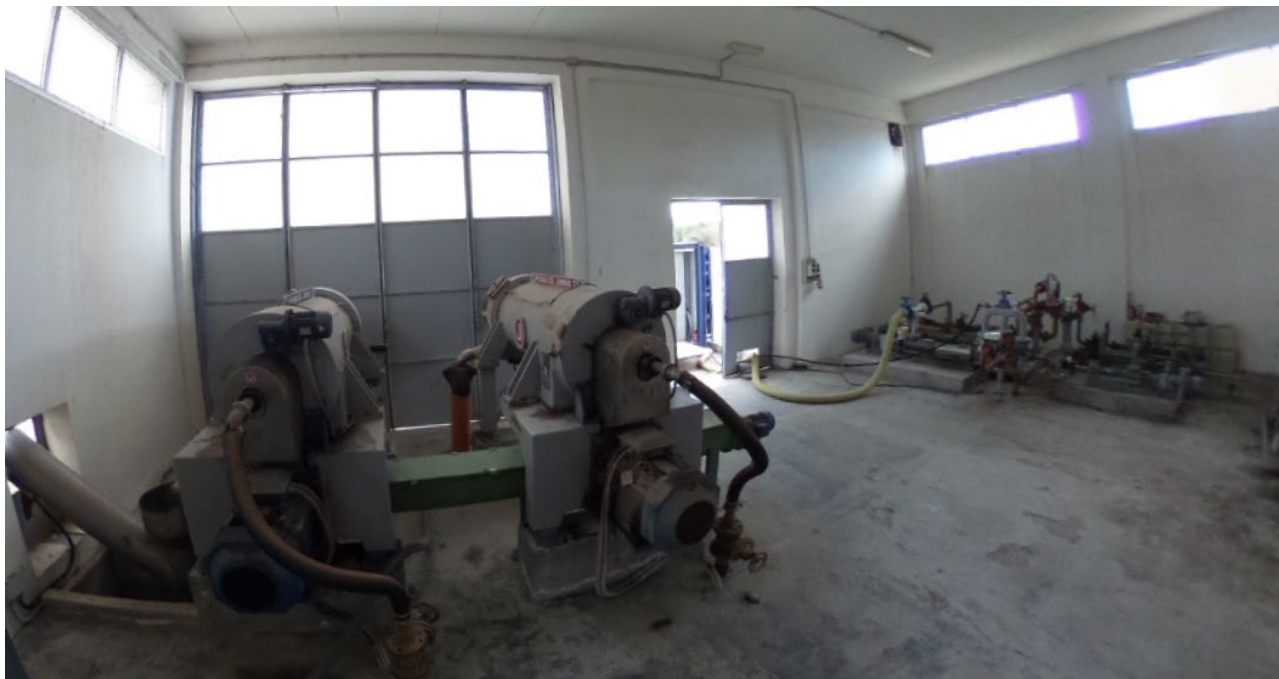
Figura 32 – Comparto di disidratazione fanghi dismesso
