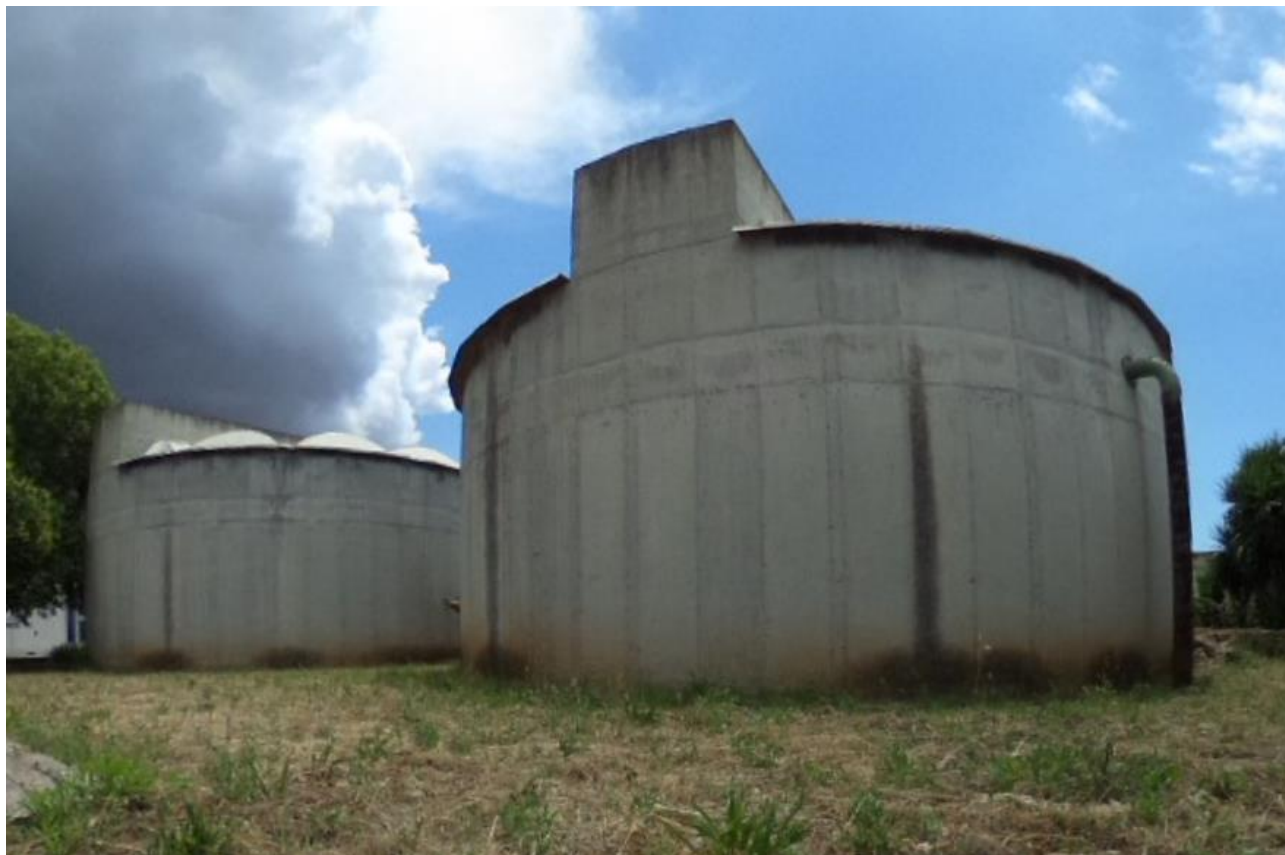
Figura 21 – Comparto di ispessimento fanghi
