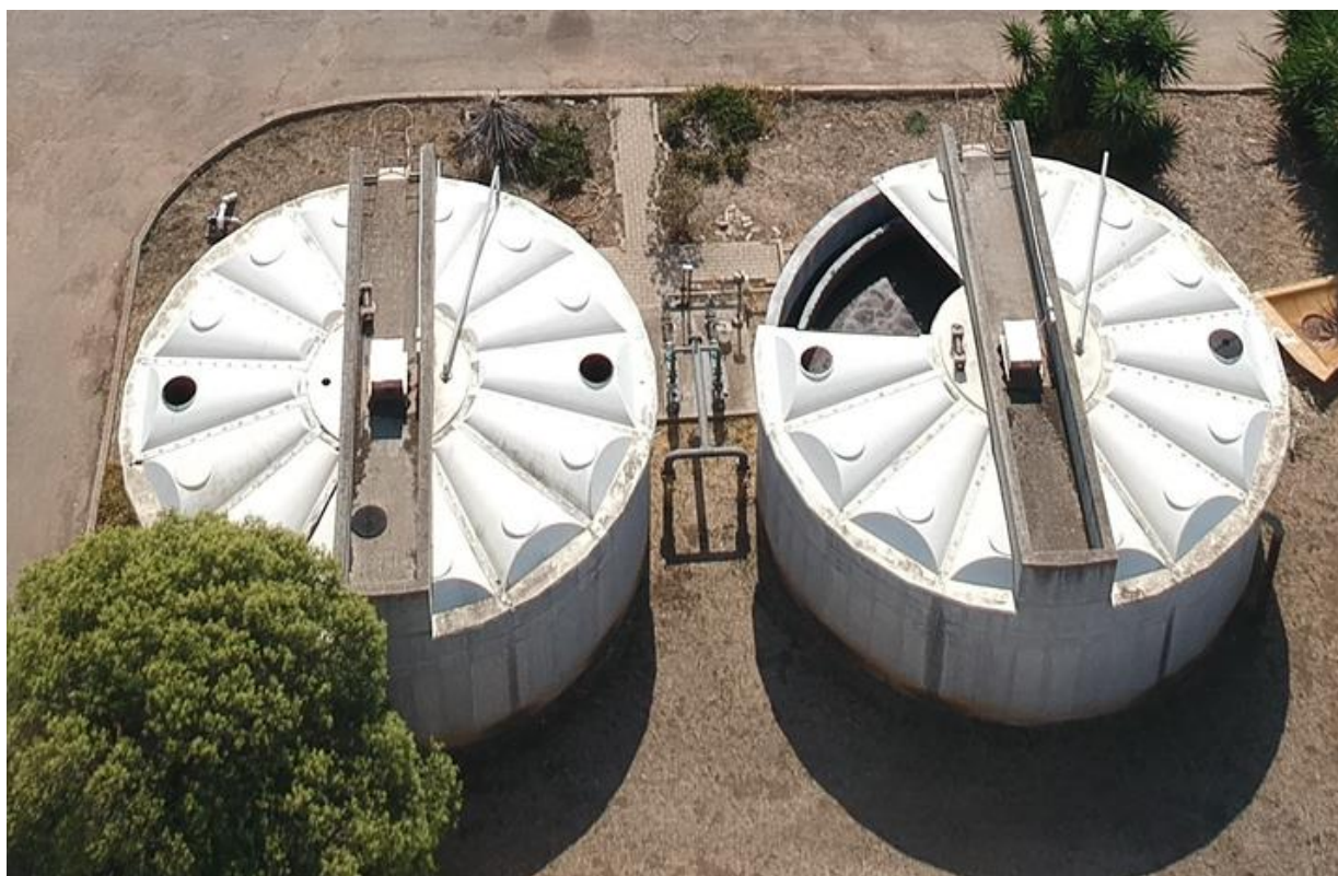
Figura 20 – Comparto di ispessimento fanghi
