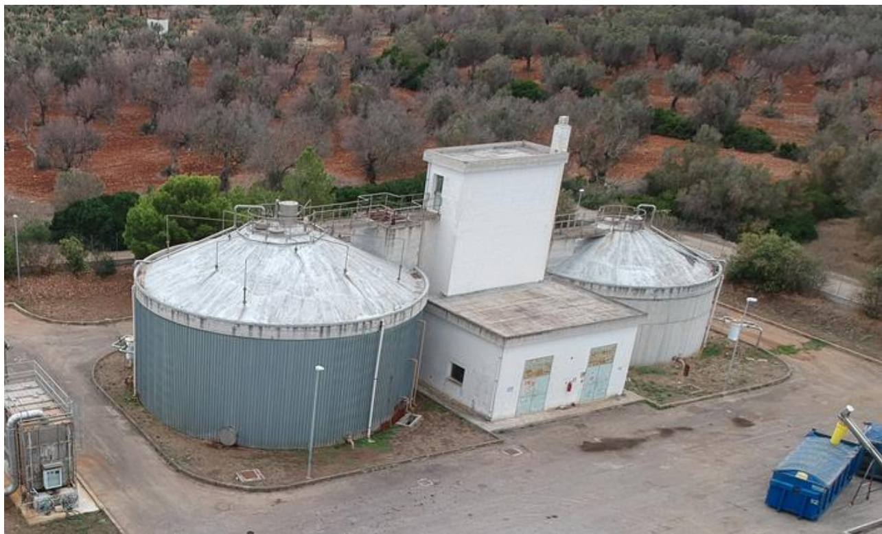
Figura 22 – Comparto di digestione anaerobica dei fanghi
