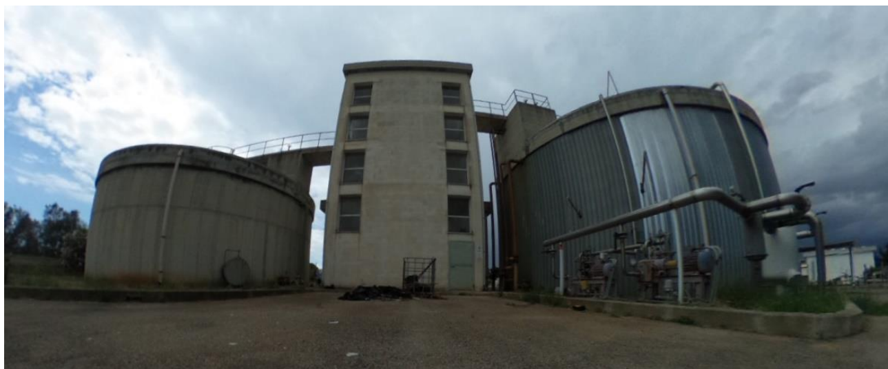
Figura 23 – Comparto di digestione anaerobica dei fanghi
