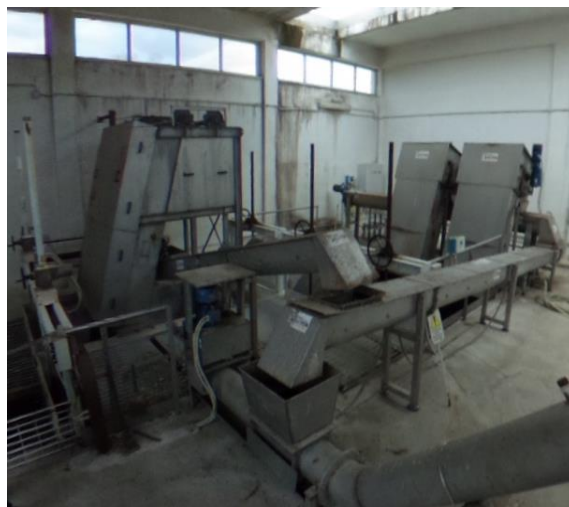
Figura 5 – Comparto di grigliatura
