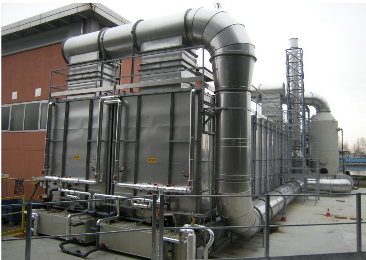
Figura 51 - Unità modulare Biotricking
