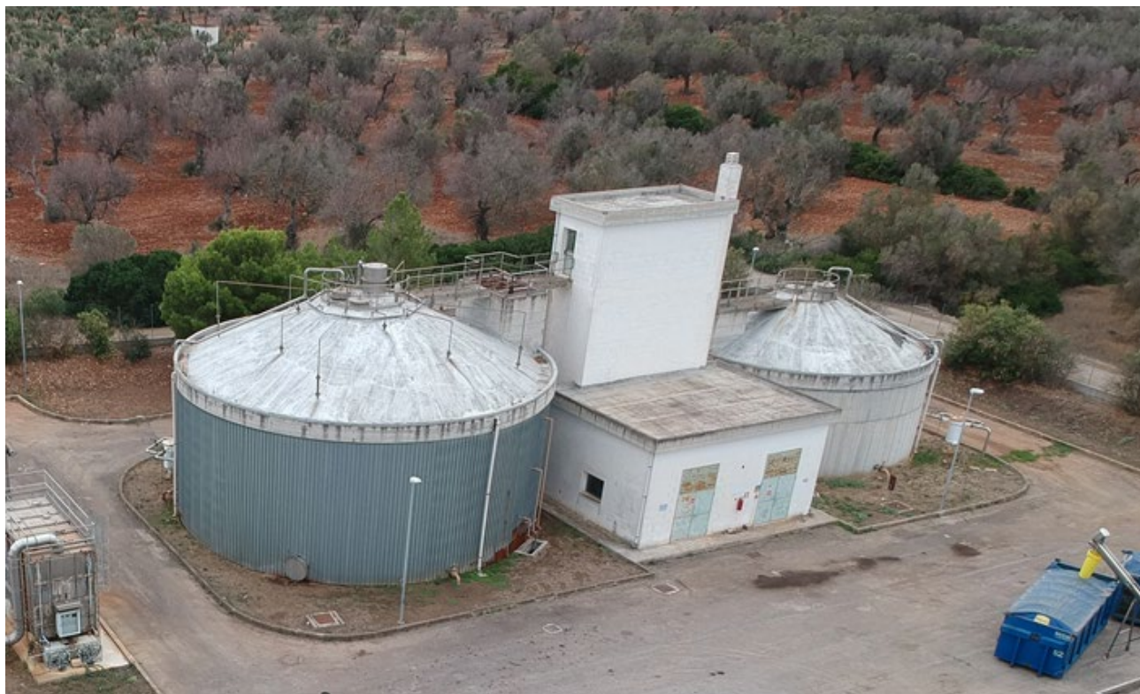
Figura 29 – Comparto di digestione anaerobica dei fanghi
