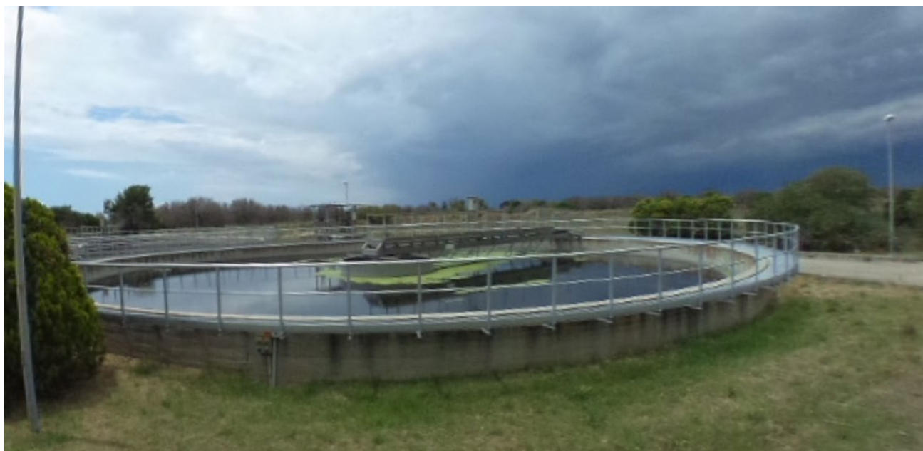
Figura 22 – Comparto di sedimentazione secondaria
