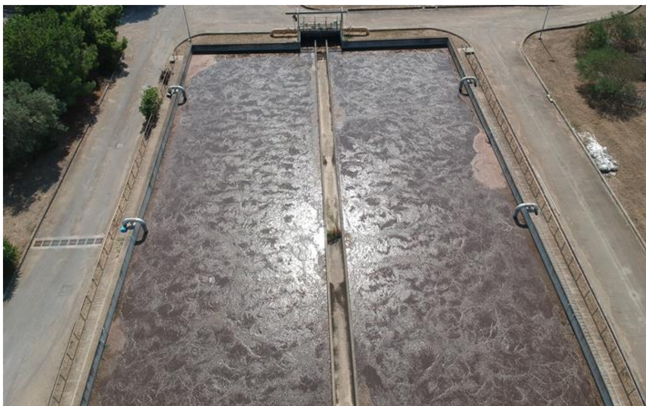
Figura 12 – Foto aerea – comparto di ossidazione/nitrificazione
