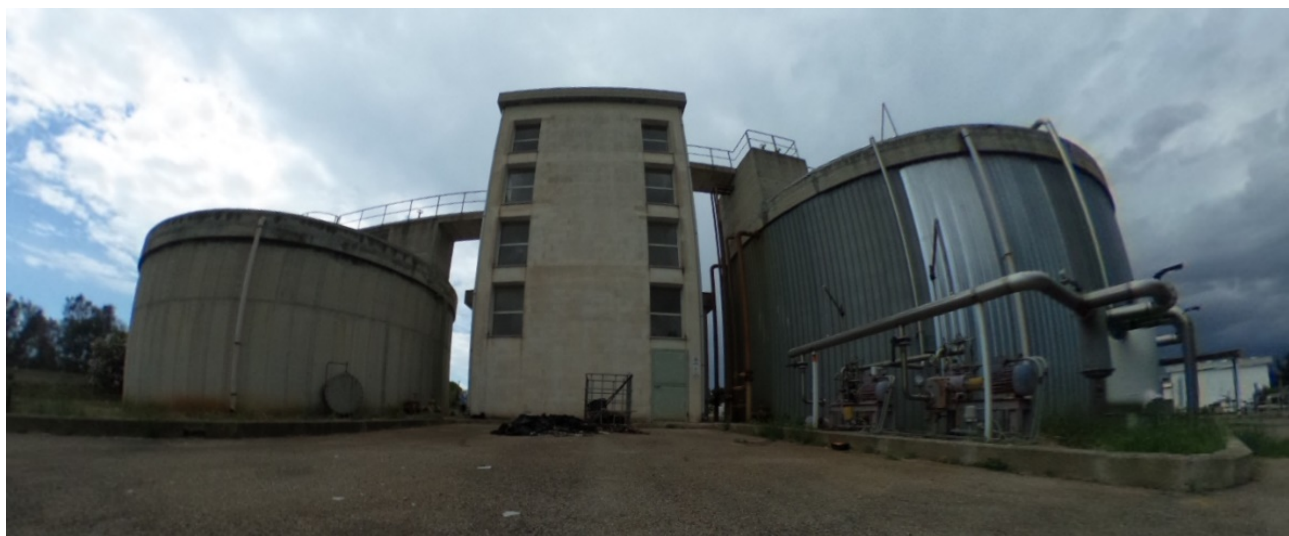
Figura 30 – Comparto di gestione anaerobica dei fanghi
