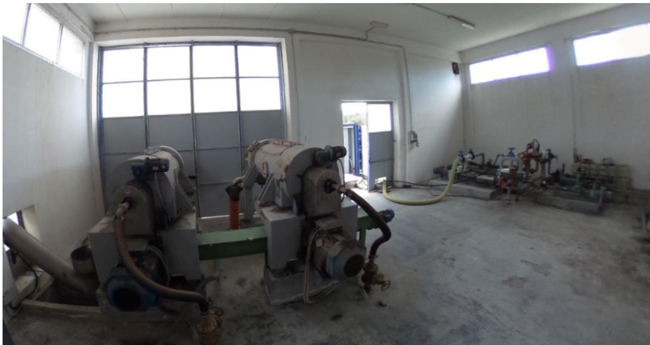
Figura 25 – Comparto di disidratazione fanghi dismesso
