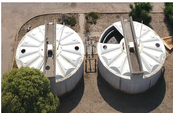
Figura 16 - Vista sul comparto ispessimento fanghi
