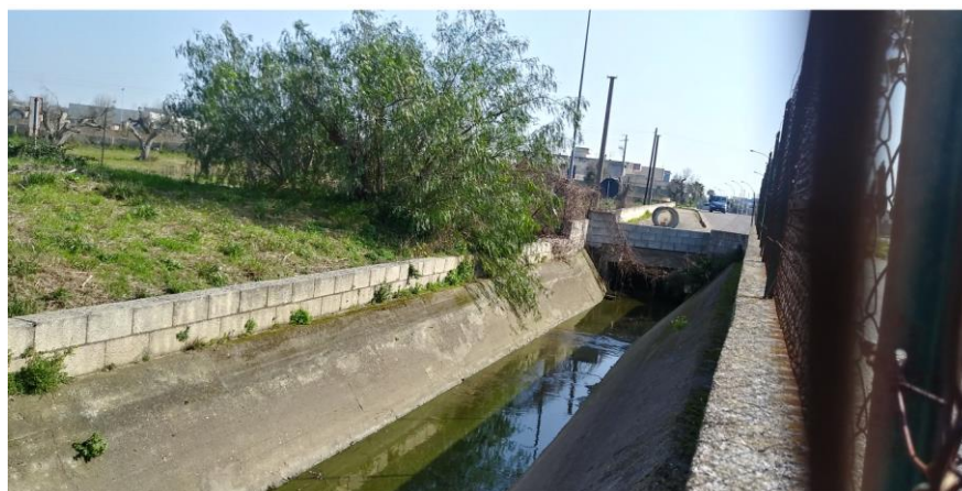
Figura 11 – Canale a cielo aperto a sezione trapezoidale in arrivo all'interno del recapito finale
