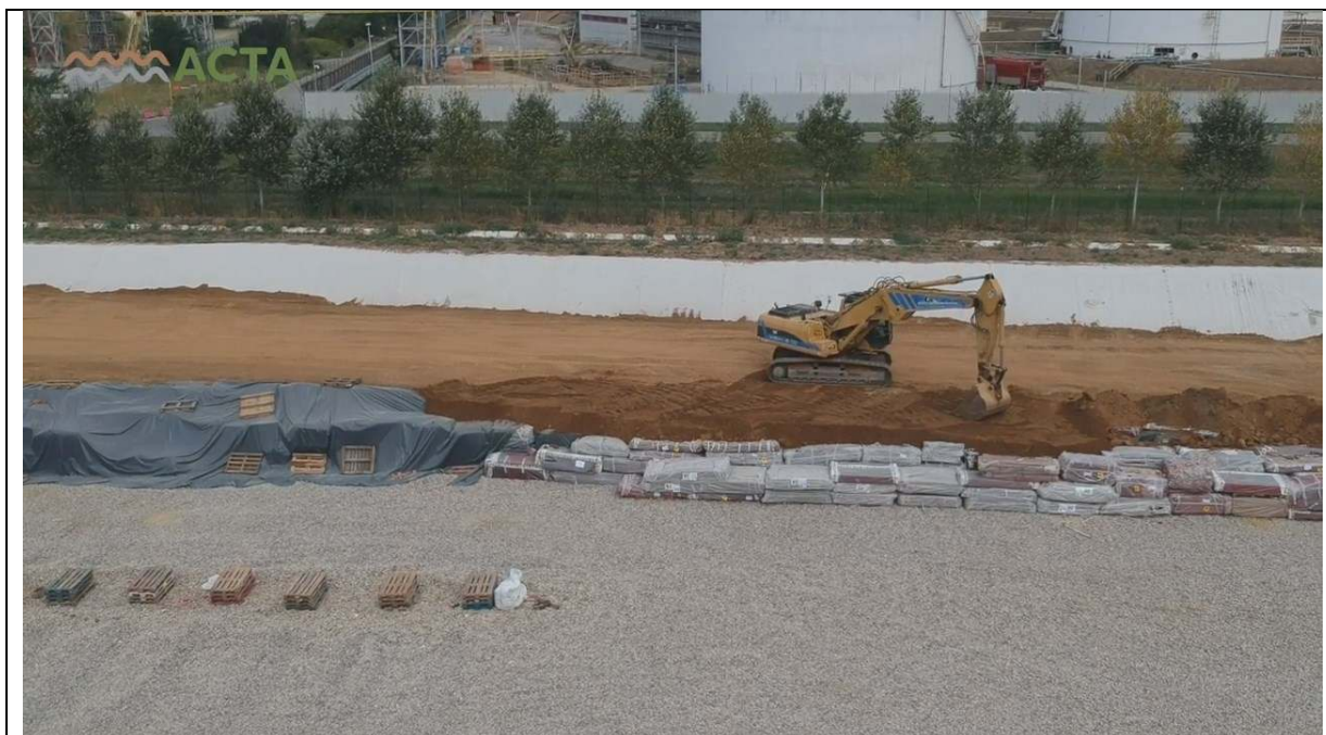
Fig. 4 – Come foto precedente, particolare del fronte di abbancamento dei rifiuti con mezzo pesante (escavatore cingolato) che transita al di sopra dei colli di RCA per mettere in posto la copertura interstrato dello spessore di 50 cm (Fonte: https://www.srlacta.it/ ).
