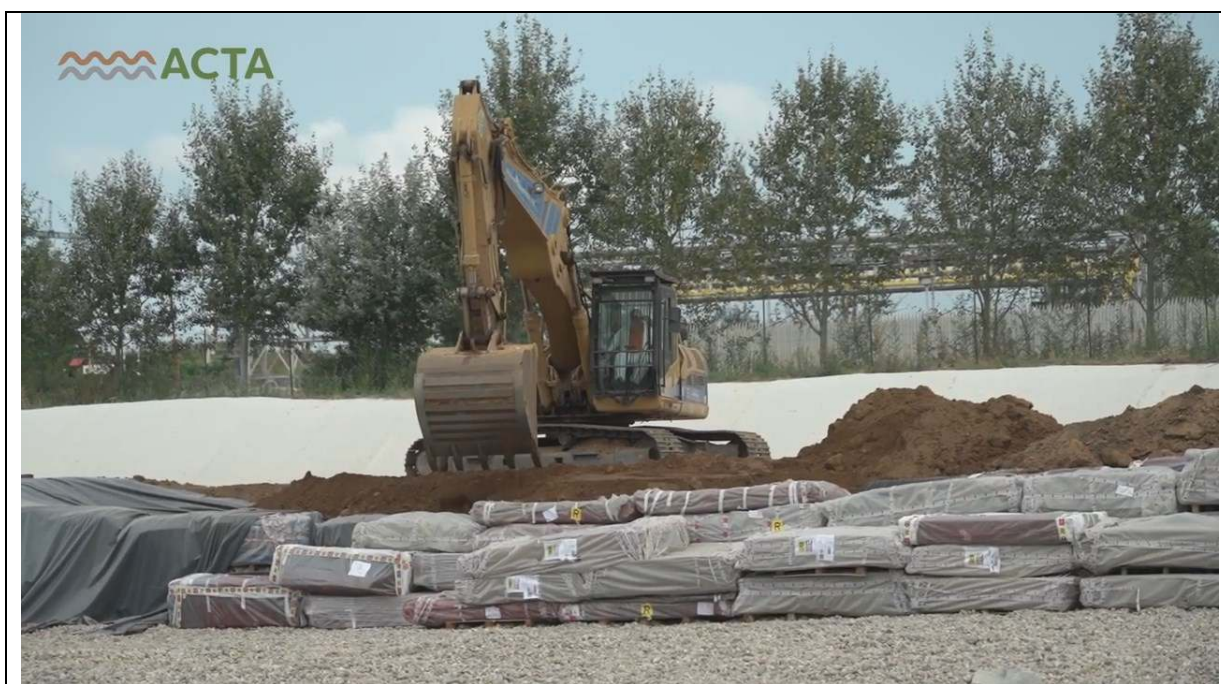
Fig. 5 – Come foto precedente, particolare delle operazioni di stesura della copertura interstrato (Fonte: https://www.srlacta.it/ ).
