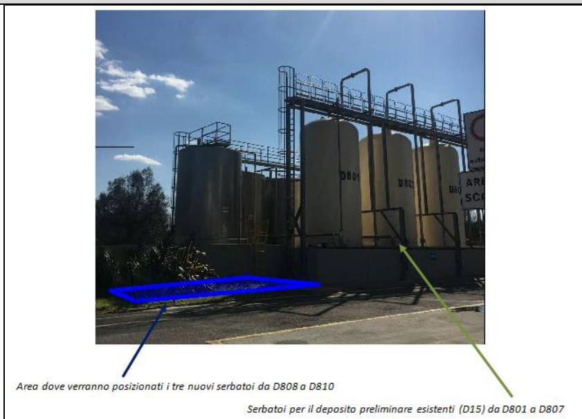
Figura 8 – Serbatoi per deposito preliminare rifiuti non pericolosi
