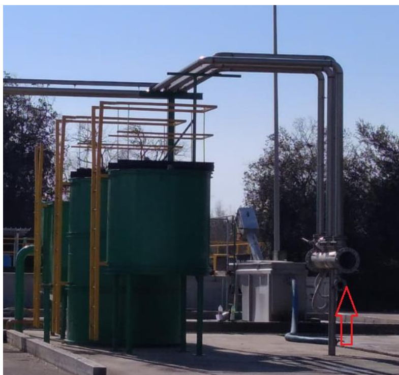
Punto di immissione rifiuti in ingresso unico Pi3 per i moduli B dove collegare la macchina
