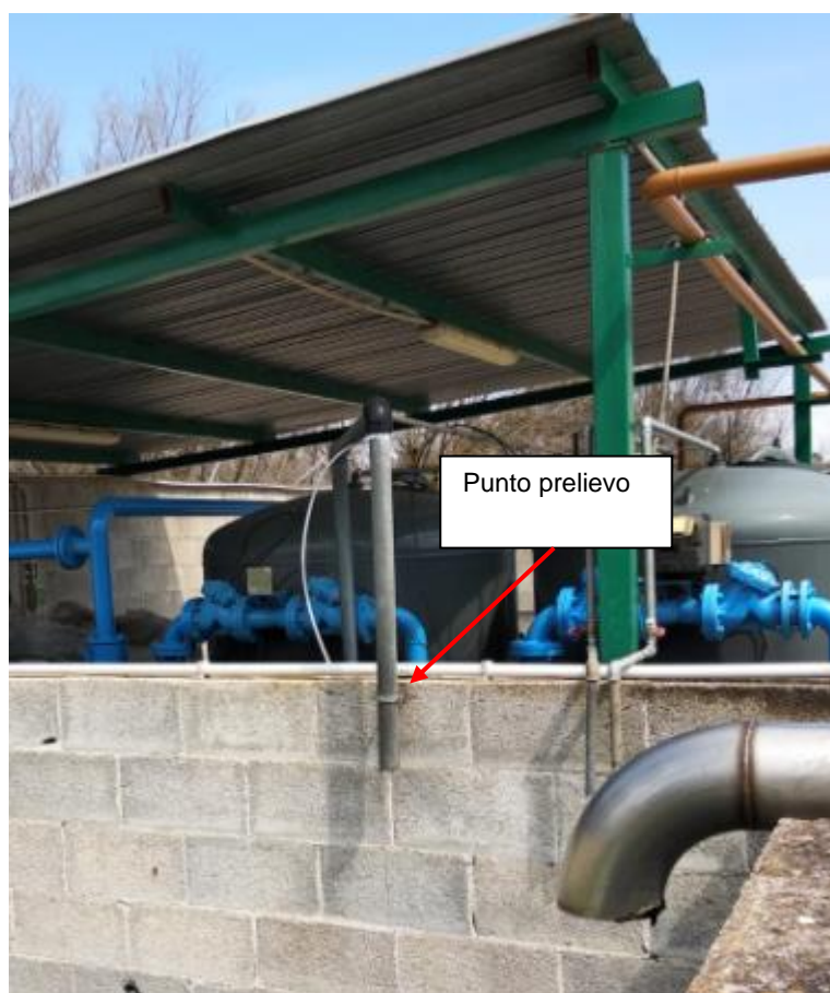
Vasca controllo effluente dopo le filtrazioni
