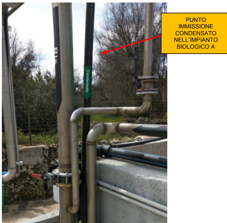
Modulo Biologico A con indicazione punto immissione condensato
