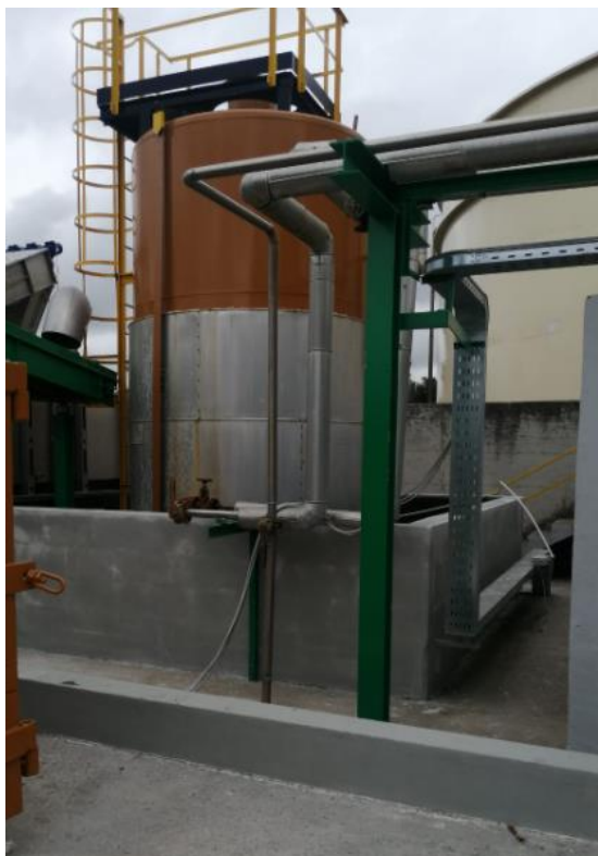
Serbatoio esistente per il deposito preliminare dei rifiuti pericolosi D811
