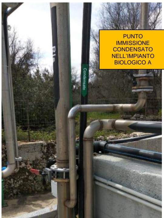
Modulo Biologico A con indicazione punto immissione condensato
