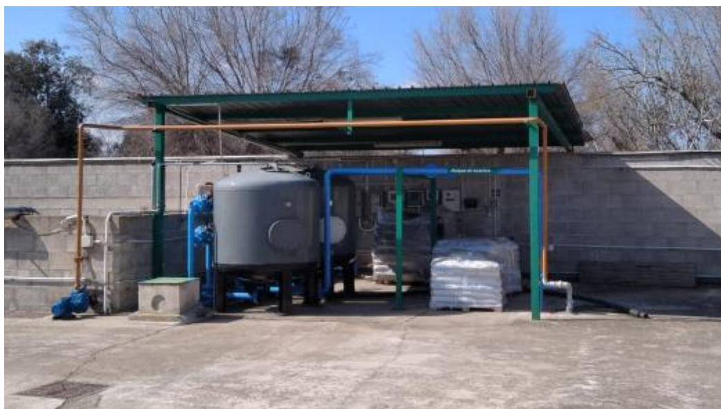
Filtri sabbia e carbone esistenti
