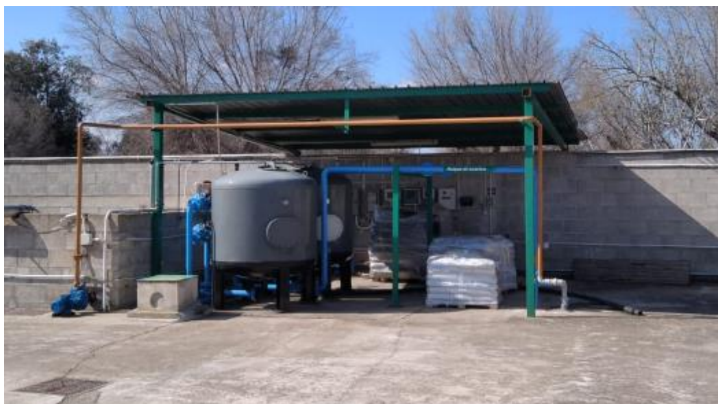
Filtri sabbia e carbone esistenti
