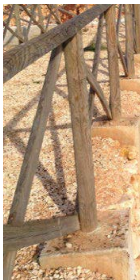
Figura 2 – Esempio di parapetto in staccionata di castagno
