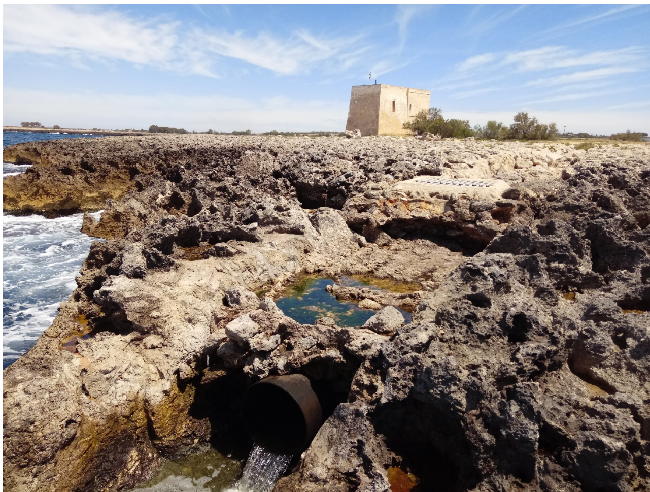
Figura 6 – Scarico a mare depuratore di Nardò
