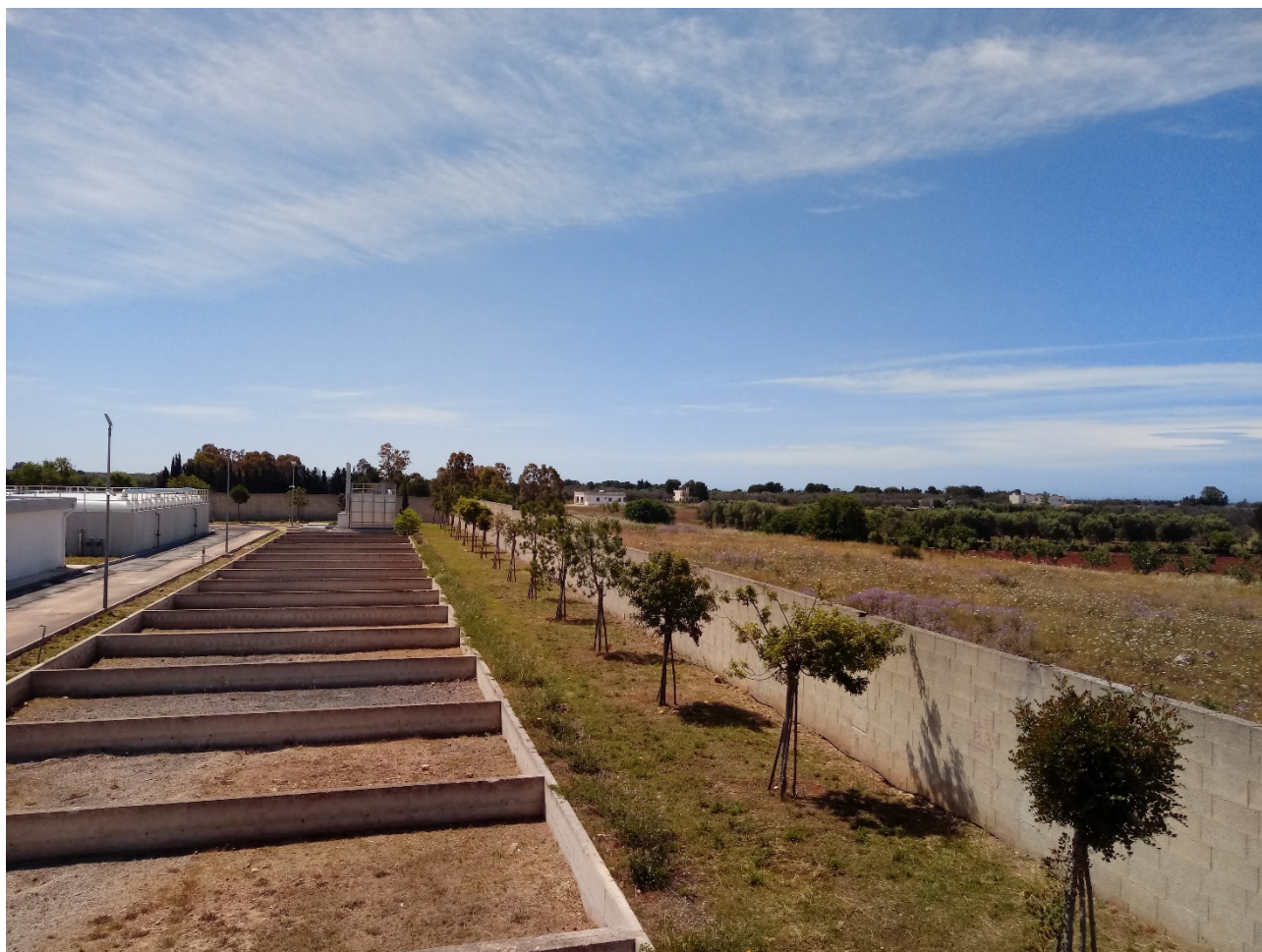
Figura 4 – Letti di essiccamento dell'impianto di depurazione di Porto Cesareo
