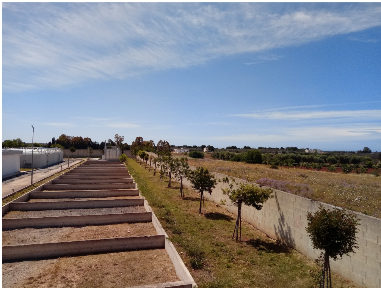
Figura 12 – Letti di essiccamento all'interno del perimetro del depuratore di Porto Cesareo
