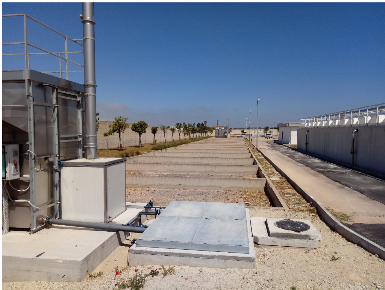
Figura 3 – Letti di essiccamento dell'impianto di depurazione di Porto Cesareo
