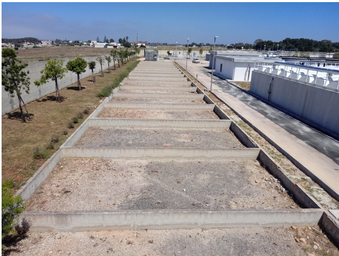
Figura 11 – Letti di essiccamento all'interno del perimetro del depuratore di Porto Cesareo
