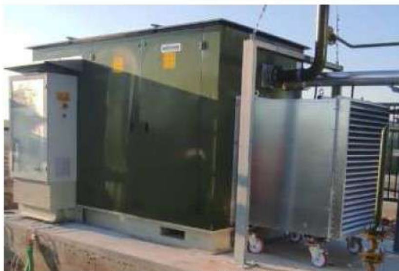
Esempio compressore versione WSS (75 dB(A)) + quadro
