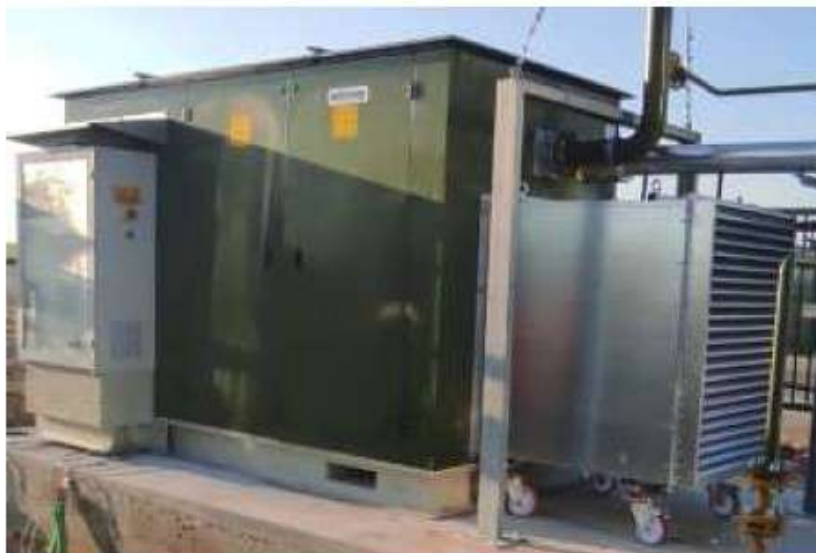
Esempio compressore versione WSS (75 dB(A)) + quadro
