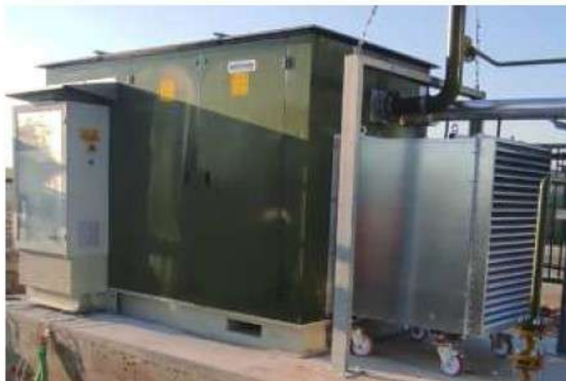
Esempio compressore versione WSS (75 dB(A)) + quadro
