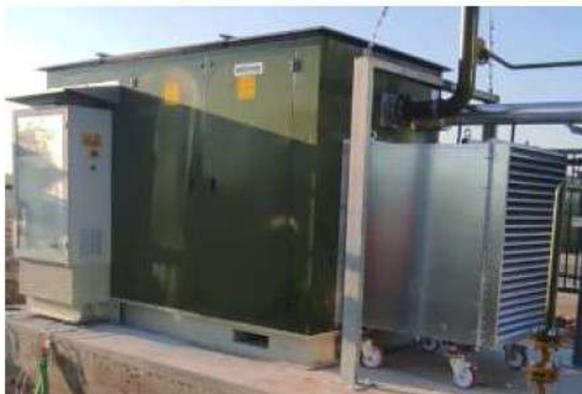
Esempio compressore versione WSS (75 dB(A)) + quadro
