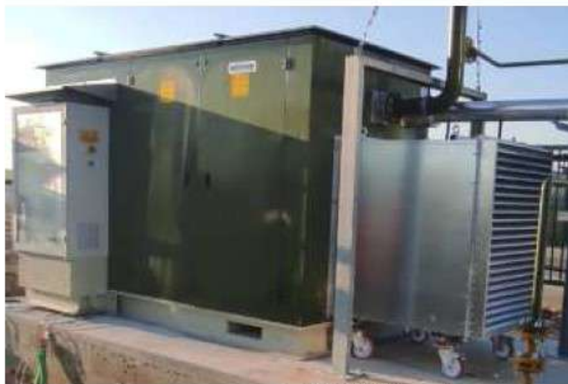
Esempio compressore versione WSS (75 dB(A)) + quadro
