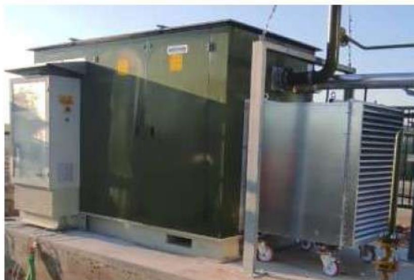
Esempio compressore versione WSS (75 dB(A)) + quadro
