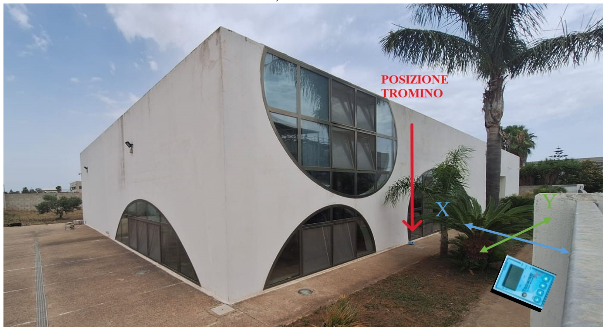
Figura 2. a) In alto, foto del bruciatore. b) in basso, foto della palestra e la posizione della terna velocimetrica+accelerometrica per la misura delle vibrazioni (Tromino® di MoHo s.r.l.), con indicazione del suo orientamento.
