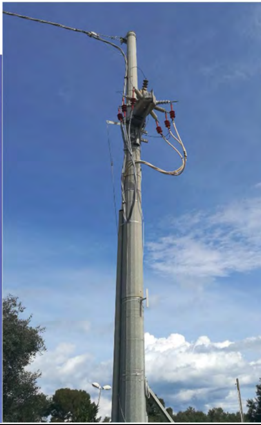
Particolare di sostegno poligonale in lamiera (amarro semplice + IMS su palo)
