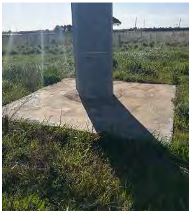
Particolare di fondazione monolitica affiorante
