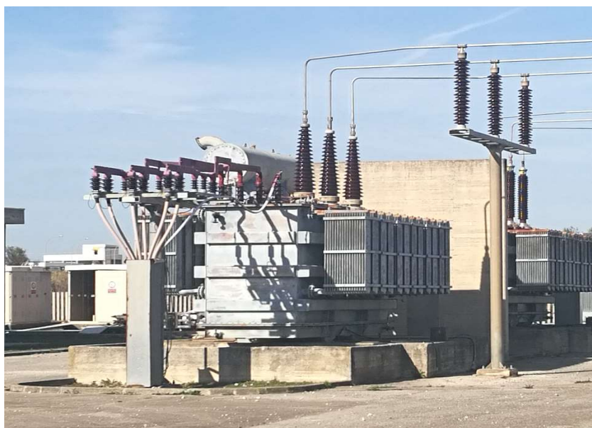
Tipico trasformatore di potenza AT/MT ONAN
