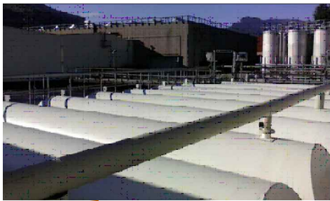
Copertura con tegoli in PRFV
