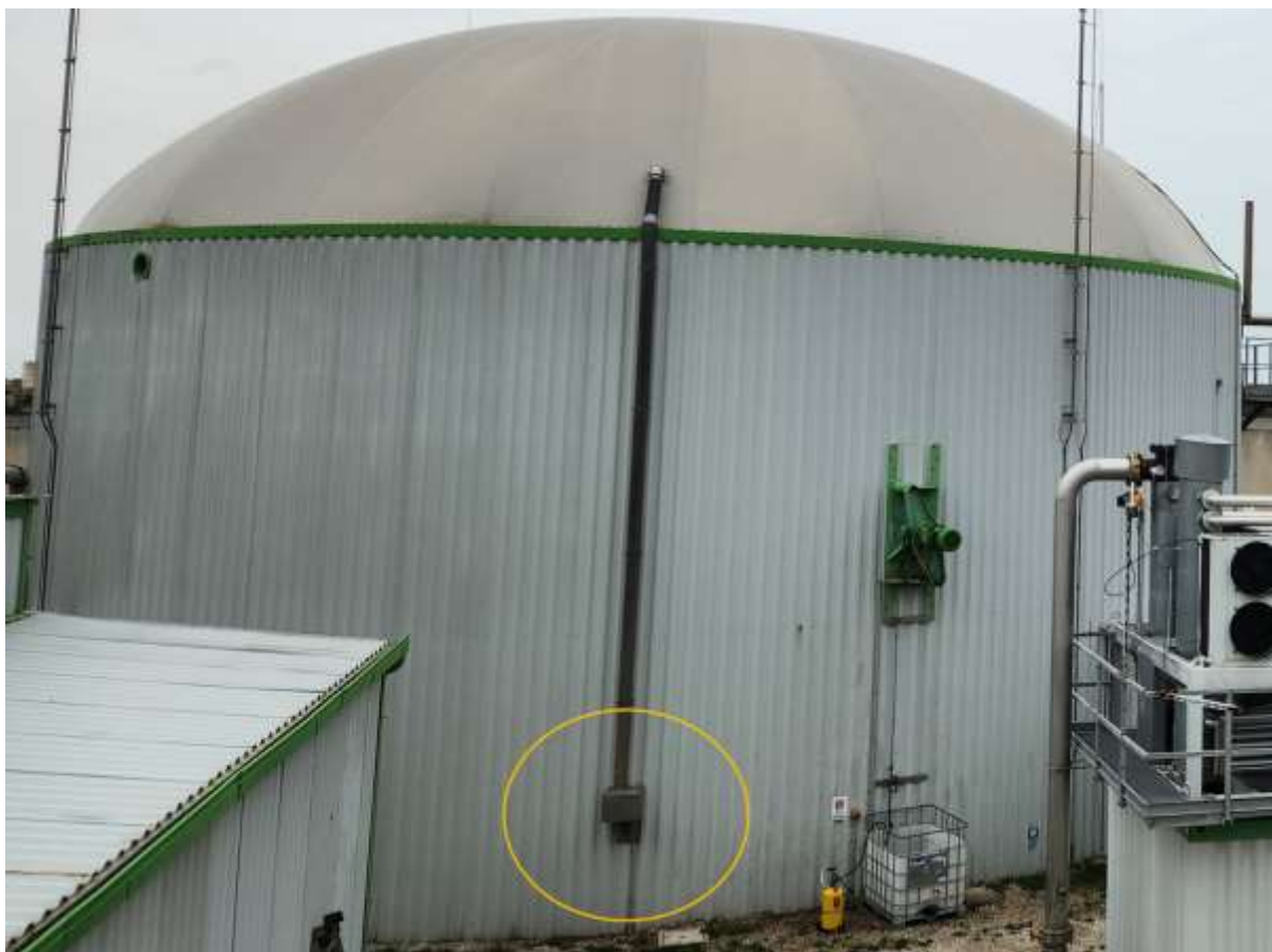
Figura 1. Ventilatore asservito al mantenimento della cupola gasometrica del fermentatore COCCUS B
