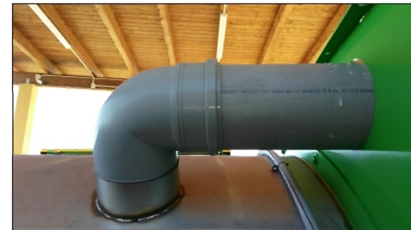
PARTICOLARE FOTOGRAFICO DELLA CONDOTTA DEGLI EFFLUENTI GASSOSI IN USCITA DALLA PRIMA CAMERA
