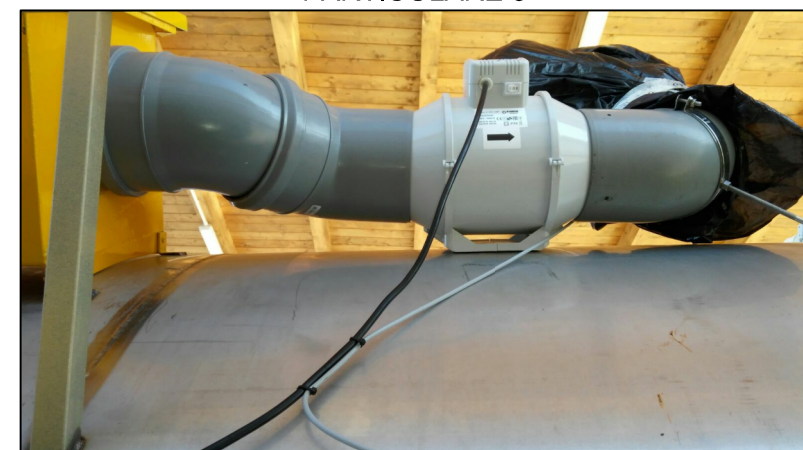
PARTICOLARE FOTOGRAFICO DELLA CONDOTTA DEGLI EFFLUENTI GASSOSI IN USCITA DAL BIOFILTRO
