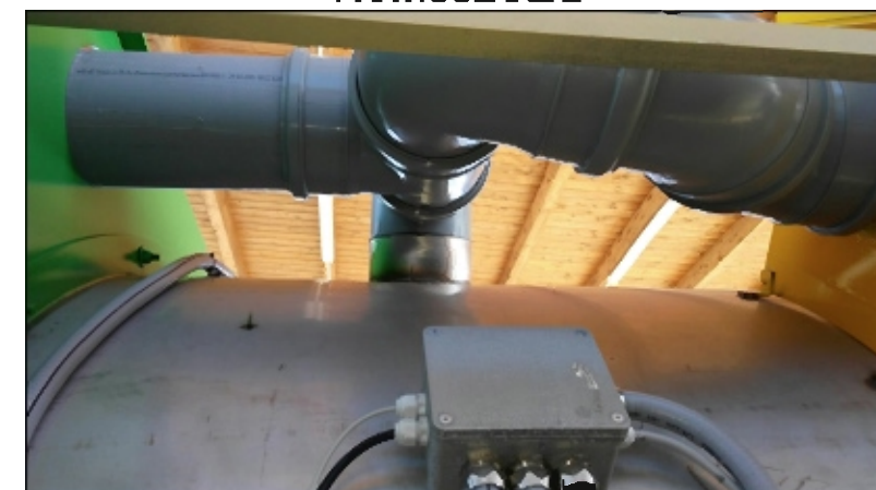
PARTICOLARE FOTOGRAFICO DELLA CONDOTTA DEGLI EFFLUENTI GASSOSI IN USCITA DALLA SECONDA CAMERA E DIRETTI AL BIOFILTRO
