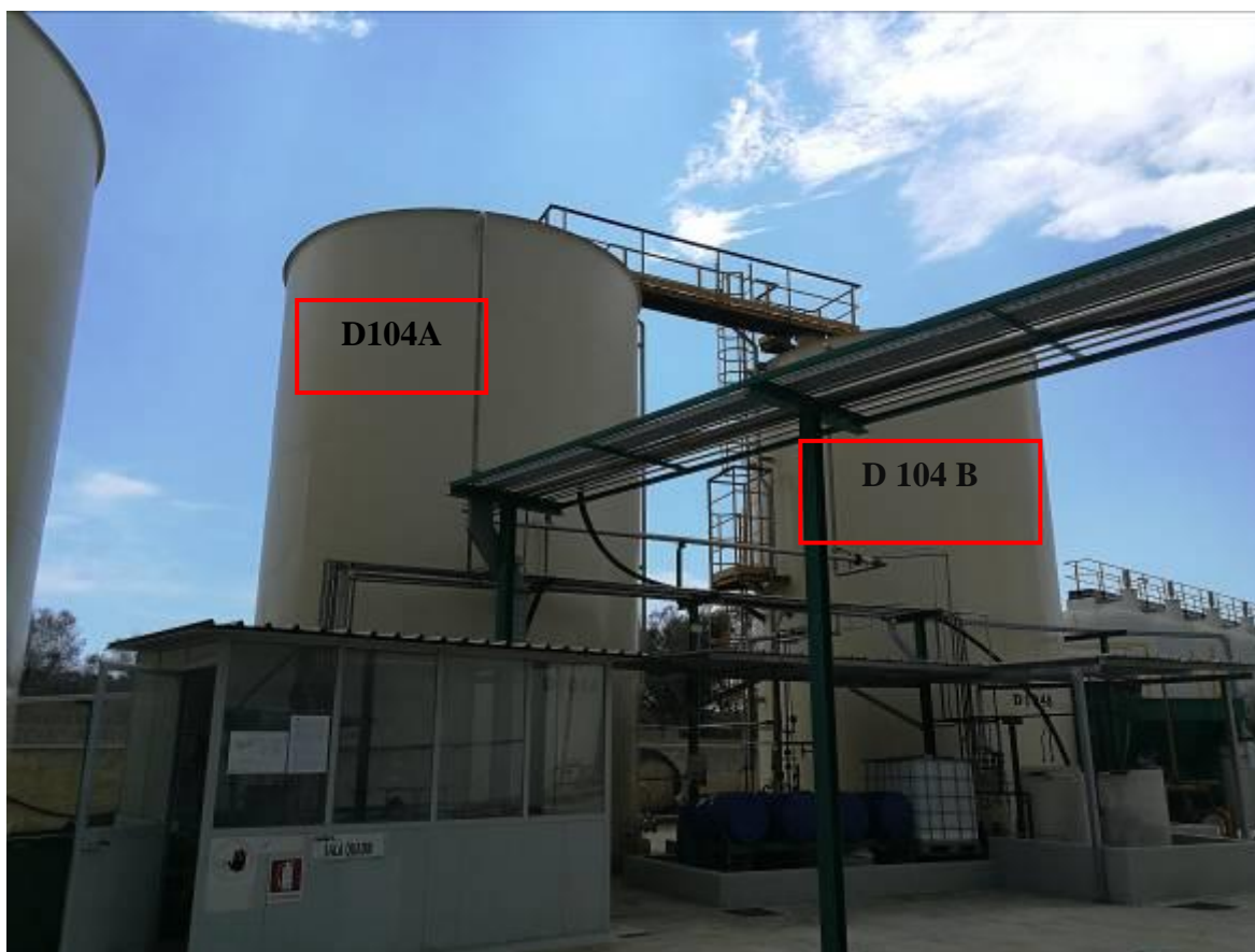
Figura 2 – Serbatoi alimento sezione termica
