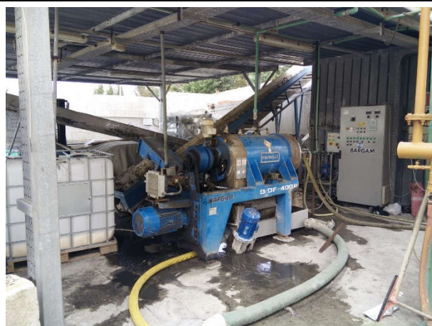
Particolare Stazione di disidratazione 1: Centrifuga fanghi
