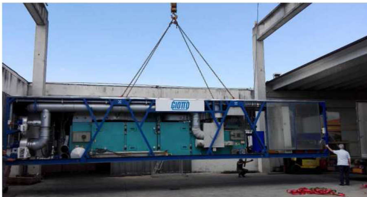
Stazione di disidratazione 2: disidratatore a nastro
