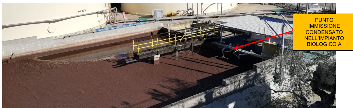
Figura 6 – Modulo Biologico A con indicazione punto immissione condensato
