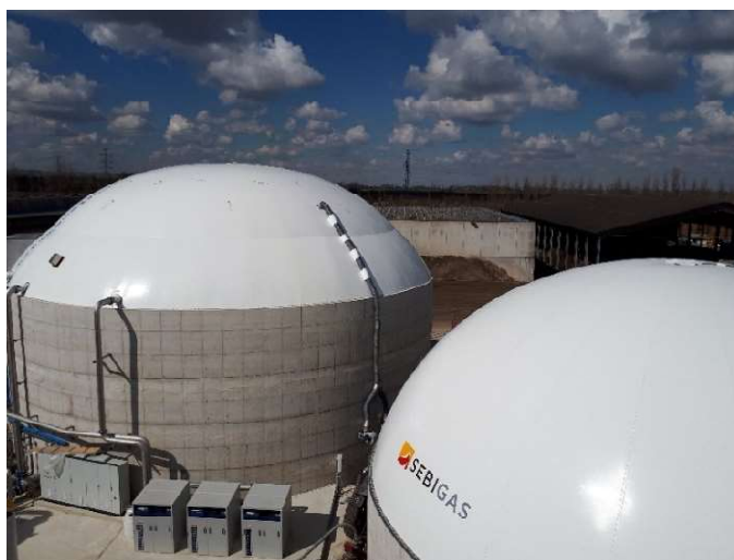
Vasca di stoccaggio con copertura gasometrica
