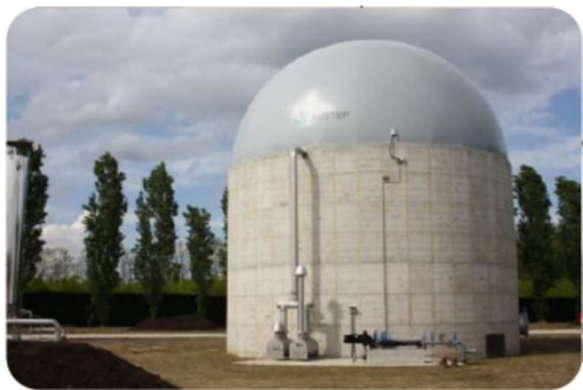
Figura 17-5 Digestore freddo
