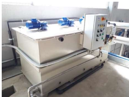
Stazione di dosaggio polielettrolita
