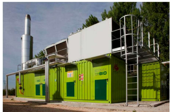
Figura 17-12 Gruppo di cogenerazione
