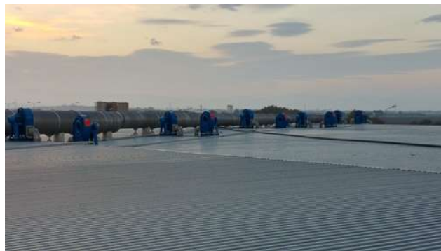
Figura 17-2 Ventilatori aspirazione aria
