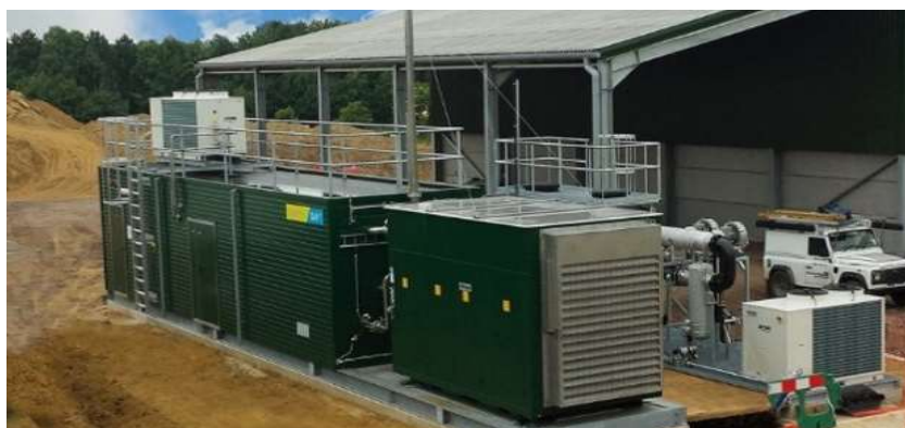
Unità di upgrading a membrane
