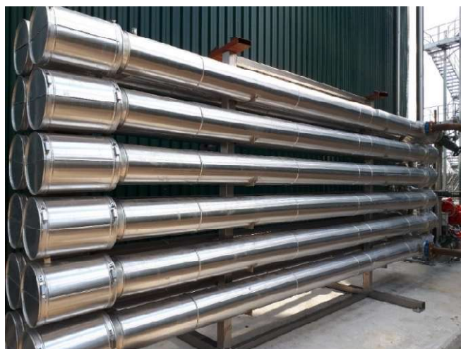
Scambiatore di calore esterno tubo in tubo
