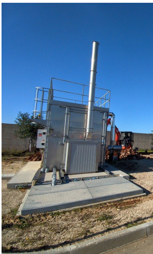
Figura 3 – Uno degli impianti di deodorizzazione biotrickling installato presso l'ID Porto Cesareo.
