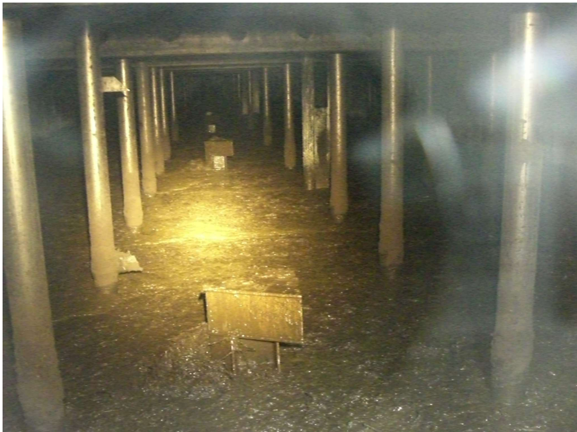
Foto dell'interno del digestore
