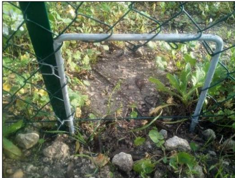
Figura 5-2 – Esempio di passaggio per la fauna lungo la recinzione
