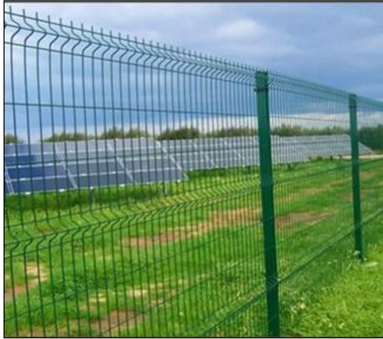
Figura 5-1- Esempi di recinzioni per impianti fotovoltaici a terra
