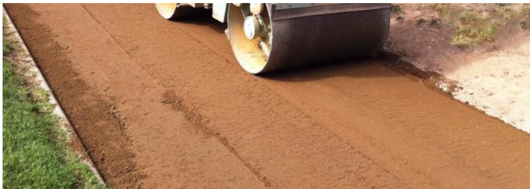
Figura 5-6 Terra stabilizzata area archeologica Crotone
