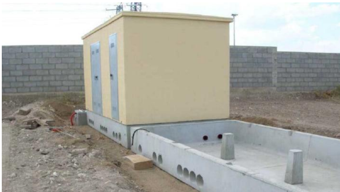
Figura 4-6 - Particolare esempio di posa in opera dei locali cabine
