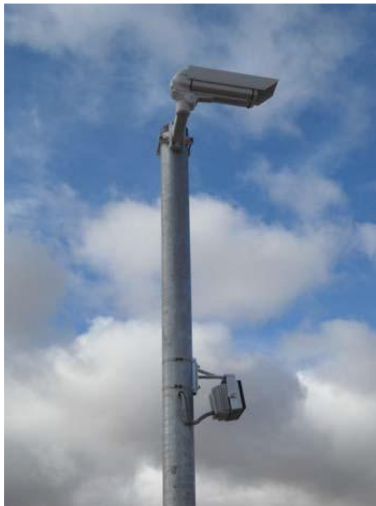
Figura 4-11 - Esempio di telecamera di video sorveglianza installata su palo
