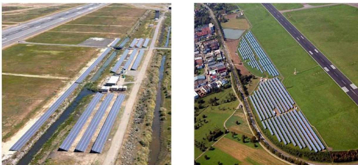
Figura 3-9 - Esempi di impianti fotovoltaici in ambito aeroportuale. La disposizione dei moduli fotovoltaici in prossimità delle piste di atterraggio/decollo non rappresenta un rischio per la sicurezza.
