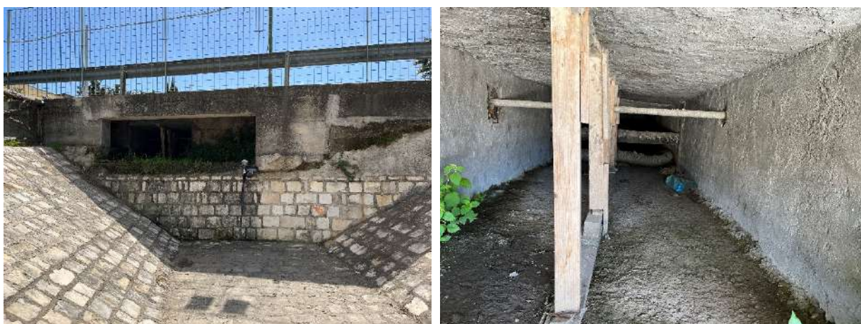
Figura 10 – Scatolare di attraversamento della SP 363 recapito di troppo pieno della vasca di laminazione
