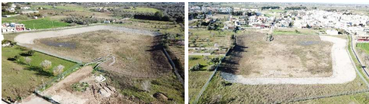
Figura 7 – Vasca di laminazione a monte del centro abitato
