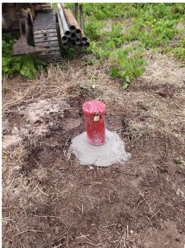
Predisposizione del piezometro
