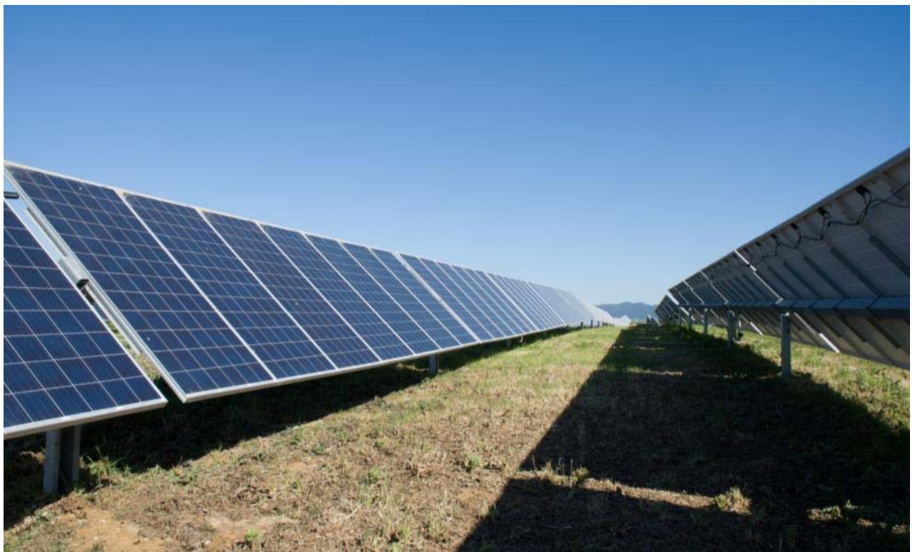
Esempio di impianto FV con strutture mobili e una fila di moduli .
