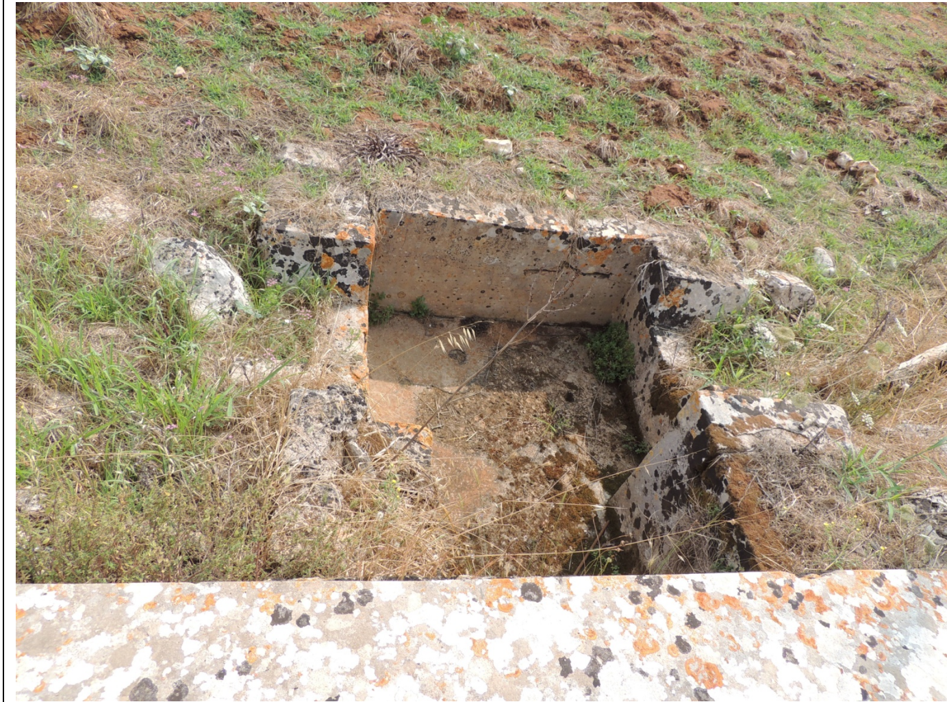
Particolari manufatti in pietra (tombino del reticolo sotto SP 325) punto C1 lato monte
