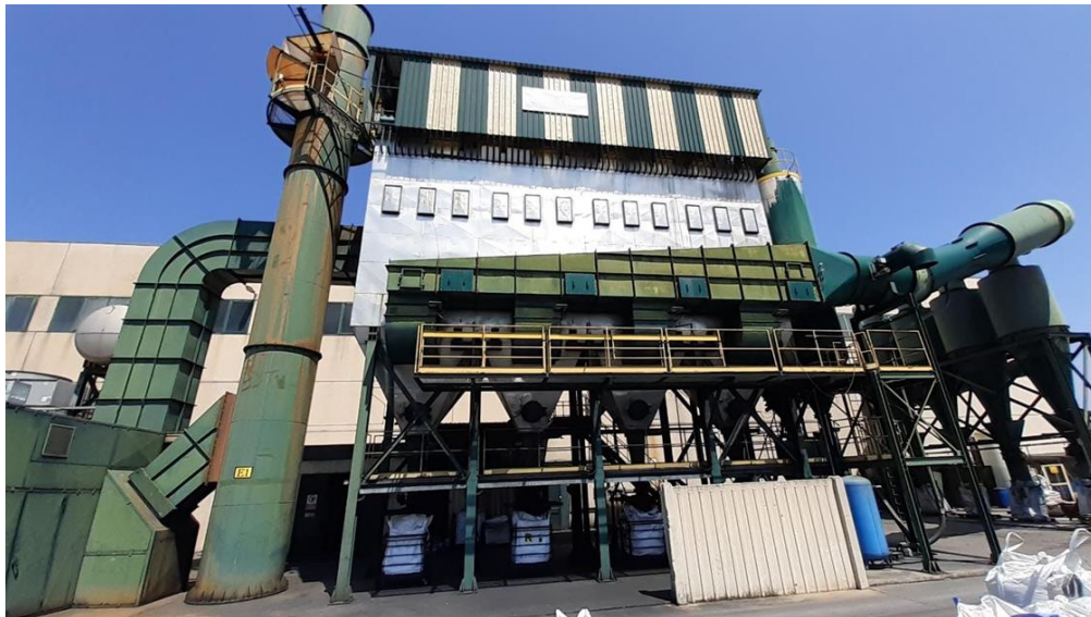
Fig.1 – Impianto di abbattimento fumi forno fusorio e forno di attesa
